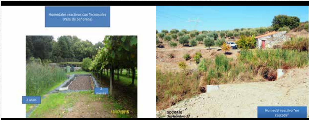
Fig. 7.- Primeros "Humedales reactivos con Tecnosoles" para el tratamiento de aguas de bodegas vitivinícolas. Pazo de Señorans (Galicia) y San Joao da Pesqueira (Portugal)- BODEGAS PAZO DE SEÑORANS, SOGRAPE y LTA-USC.
