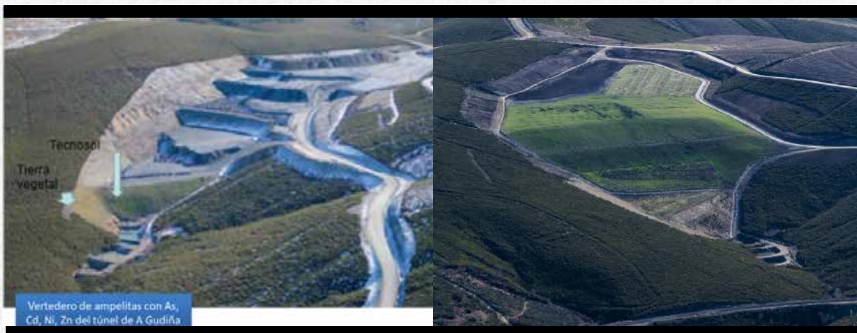
Fig 8.- Utilización preventiva de la oxidación de ampelitas arsenopiriticas y de la lixiviación de As y metales pesados en el vertedero de obradel túnel de A Gudiña. ADIF, FERROVIAL, OHL, LTA-USC y CENTRO DE VALORIZACION AMBIENTAL.
