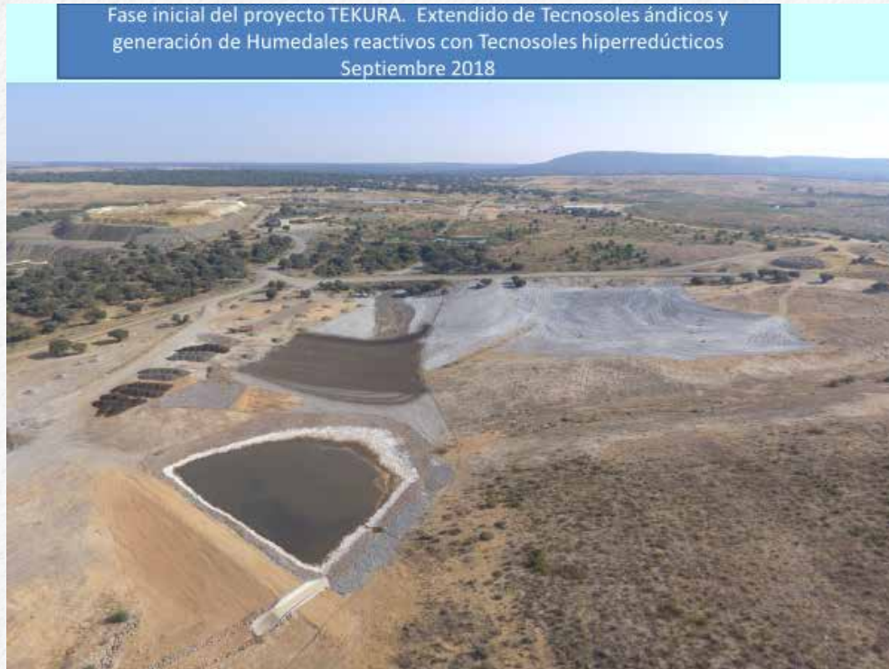
Fig. 12.- Proyecto TEKURA: Fase inicial de la construcción de los Humedales reactivos y del extendido de Tecnosoles en la mina de uranio de Saelices.
