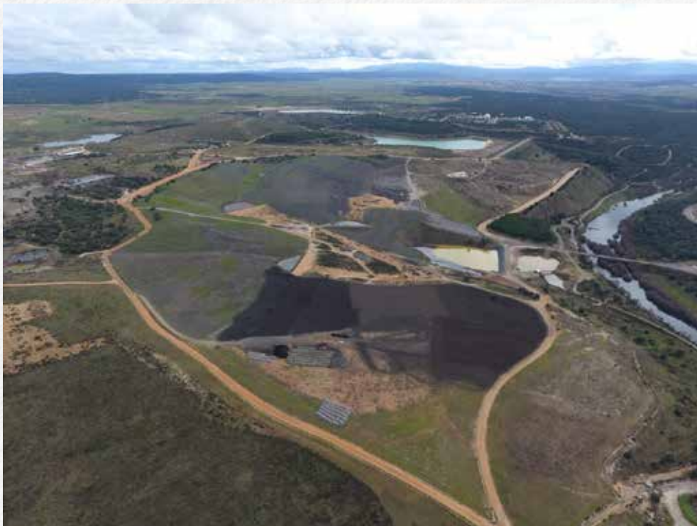
Fig. 12.-Proyecto TEKURA. Estado intermedio del extendido de Tecnosoles "a la carta" diseñados y elaborados por Centro de Valorización Ambiental, LTA-USC y EMGRISA.
